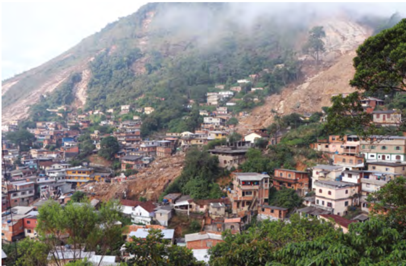
Vista do Morro da Oficina, no bairro Alto da Serra, em Petrópolis (RJ), onde dezenas de pessoas foram atingidas pela chuva que caiu no dia 15 de fevereiro
